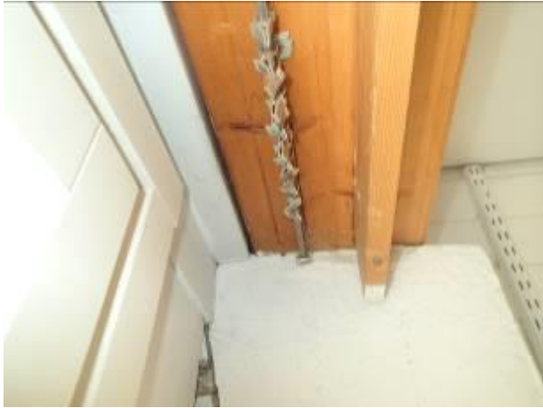
Kuva 47. Ikkunan verhokotelon ja seinärakenteen liittymä on auki.
