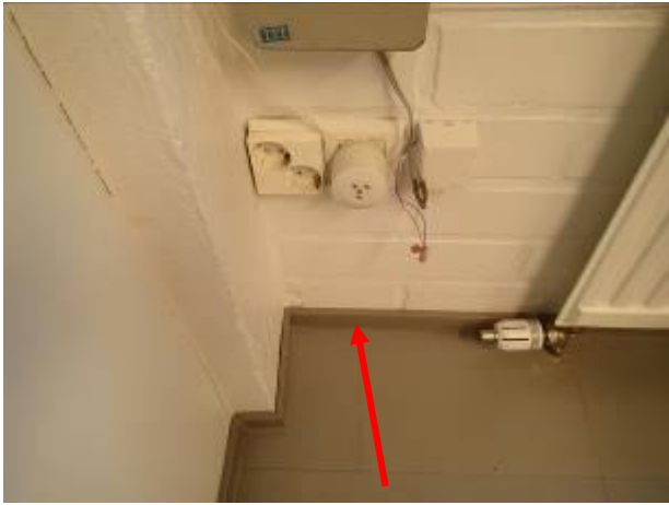
Kuva 15. RA1, tehtiin oleskelutila 120 ulkoseinään pilarin viereen.
