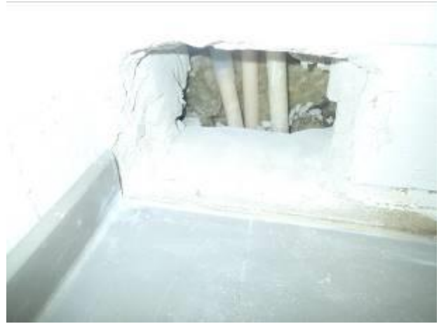
Kuva 16. Sisätiliverhouksen jälkeen on mineraalivillaa ~100 mm. Ulkovuorauksen ja mineraalivillan välissä ei ole ilmarakoa tai se on hyvin pieni. Mineraalivillan jälkeen on julkisivumuuraus. Mineraalivillasta otettiin materiaalinäyte 1, LP-tasosta +70 mm. Näytteessä oli selvää mikrobikasvua.
