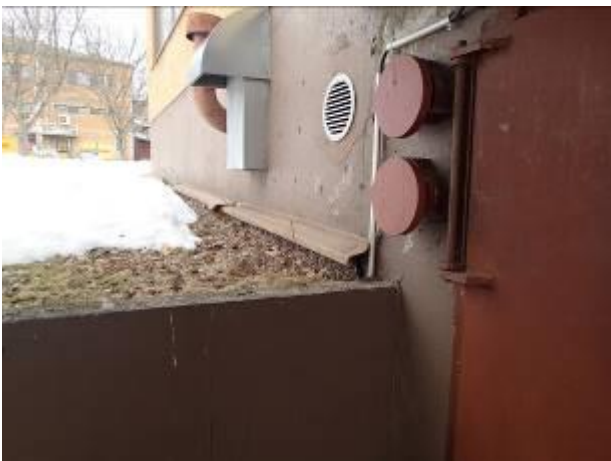
Kuva 7. Sokkelin ulkopintaan on asennettu styroxlevytys, styroxlevyn yläpuolelle asennettu vedenohjainlista.
