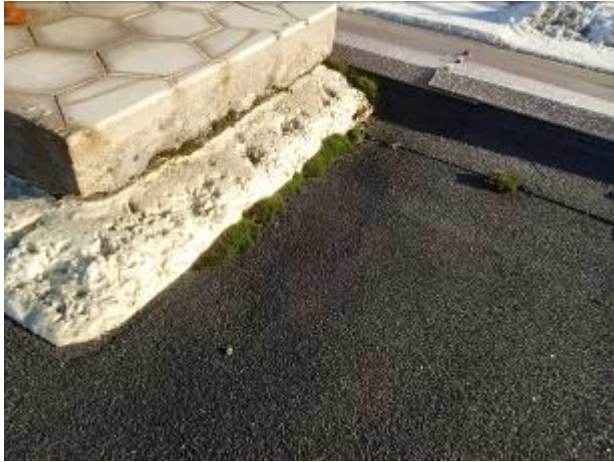
Kuva 13. Vesikatolla joissakin kohdissa kasvoi sammalta.
