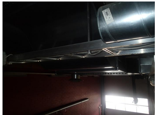
Kuva 74. TK05 tuloilmapuhallinkammiossa ei merkittävää pölykertymää.
