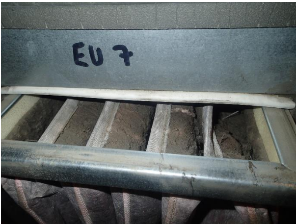
Kuva 73. TK01 tuloilmasuodattimilla runsaasti pölyä ja likaa.
