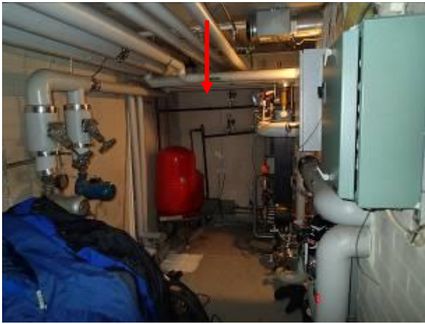
Kuva 34. Lämmönjakohuoneen ulkoseinään tehtiin rakenneavaus (RA6) LP-tasosta +1840 mm.
