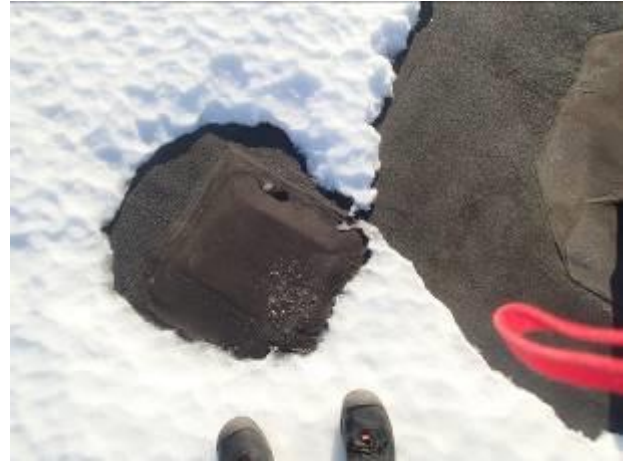
Kuva 10. Vesikatolla on tehty paikkakorjauksia.
