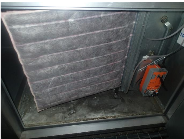
Kuva 73. TK01 tuloilmasuodattimilla runsaasti pölyä ja likaa.
