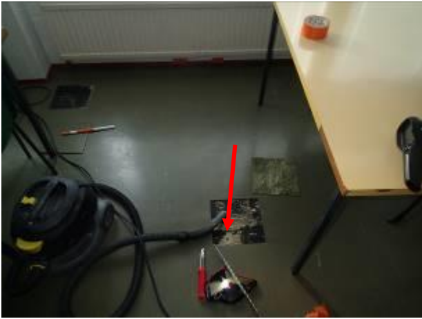
Kuva 28. Opetustilan 121 lattian tehtiin rakenneavaus RA3, josta tutkittiin opetustilan alapohjan rakennetta.
