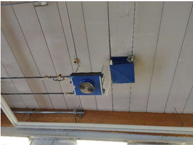
Kuva 22. Paikalla rakennettu yläpohjarakenne.
