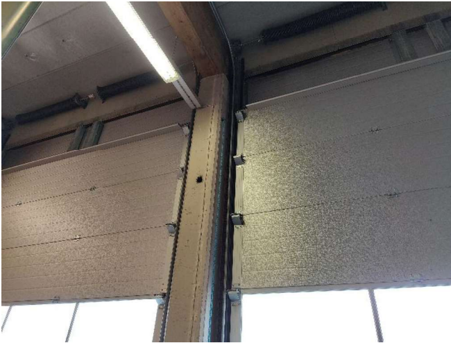
Kuva 24. Paikalla rakennettu yläpohjarakenne.
