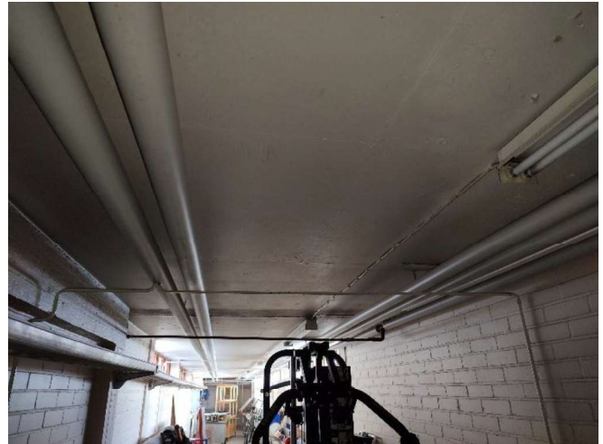
Kuva 63. Yleiskuva käytävän seinä- ja kattopinnasta.
