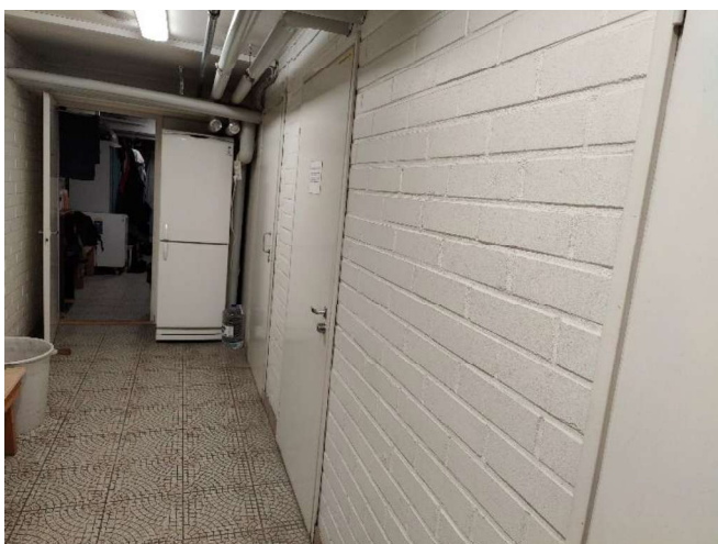
Kuva 56. Yleiskuva käytävän seinät.
