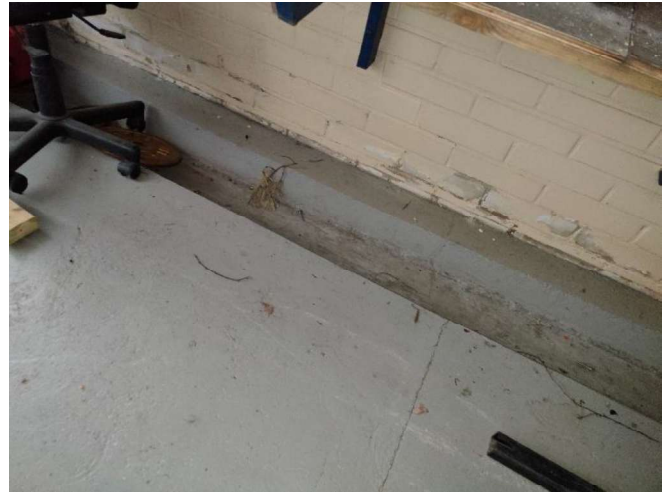
Kuva 18. Yleiskuva maanavastaisesta seinärakenteesta.
