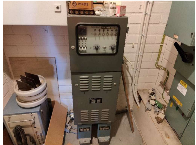
Kuva 125. Yleiskuva kompensointiparistosta.
