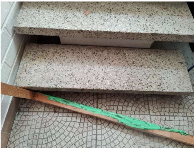
Kuva 28. Runkoportaat 1. – 2.kerrosten välillä.
