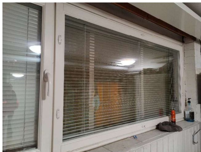
Kuva 36. Yleiskuva ikkunasta sisäpuolelta kuvattuna.
