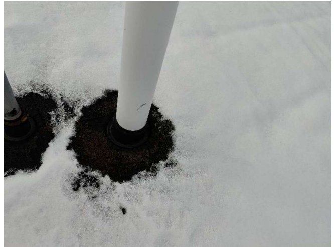
Kuva 53. Viemärin tuuletusputken läpivienti.
