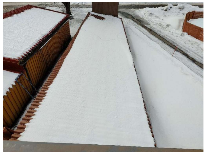
Kuva 51. Yleiskuva, tunnelin katto.
