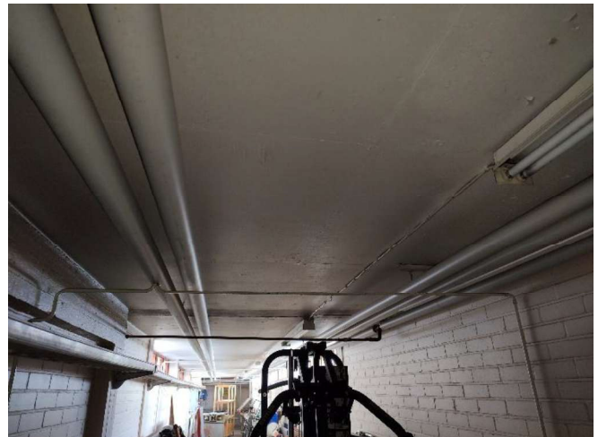
Kuva 23. Välipohjarakenteissa ei havaittuja vaurioita.
