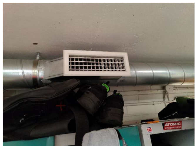
Kuva 123. Tuloilmapäätelaite.
