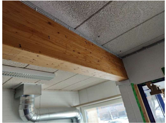
Kuva 25. Paikalla rakennettu yläpohjarakenne.
