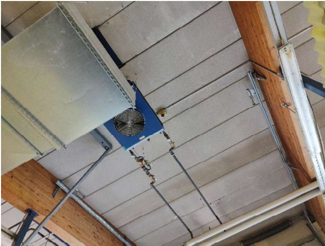
Kuva 62. Yleiskuva hallin kattopinta.
