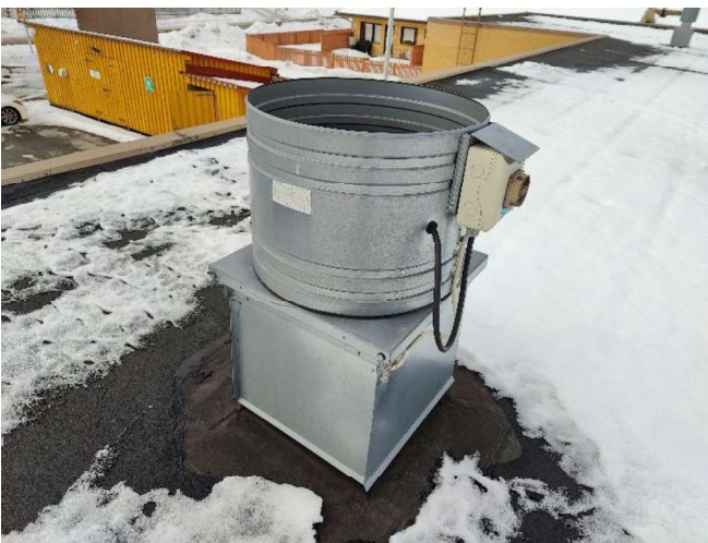
Kuva 110. Erillispositopuhallin vesikatolla.
