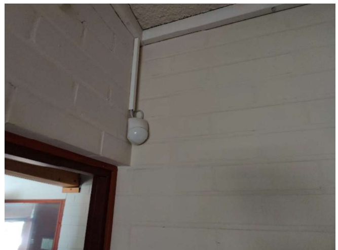
Kuva 67. Yleiskuva, toimisto-osan seinäpinta puhtaaksi muurattua seinää.
