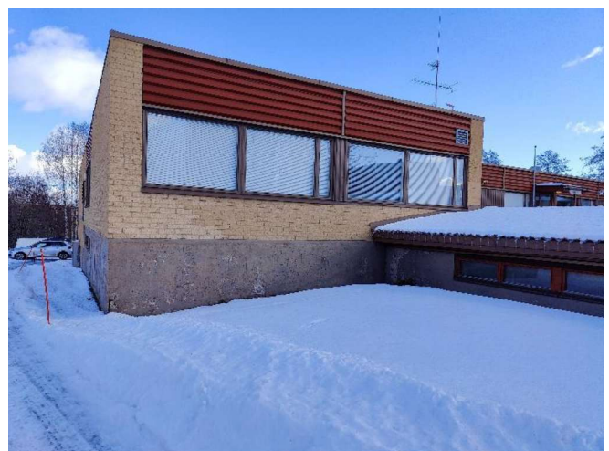
Kuva 34. Yleiskuva, toimistosiiven julkisivu.
