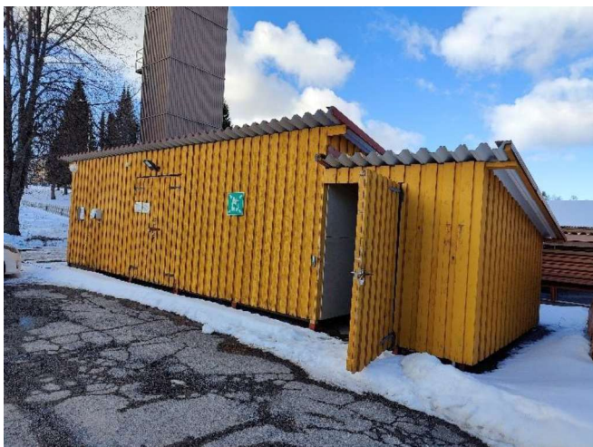
Kuva 10. Yleiskuva piha-alueen päällysteestä, varaston edusta.
