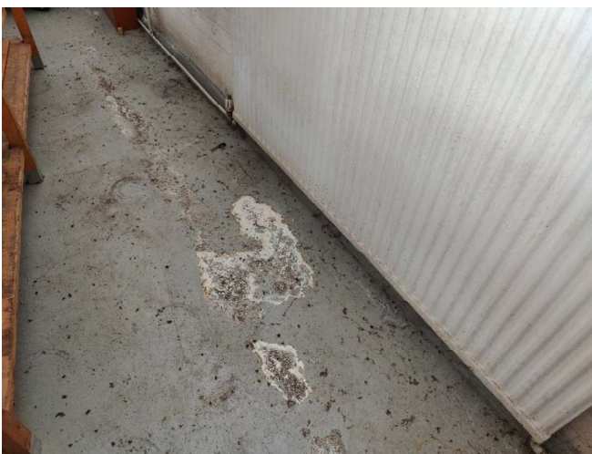
Kuva 19. Alapohja maalatuilla osilla, yleiskuva.
