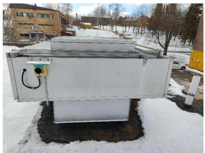
Kuva 111. Erillispositopuhallin vesikatolla.
