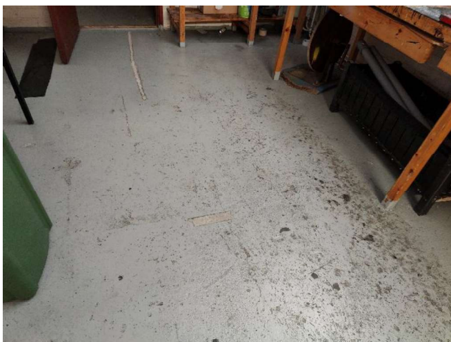
Kuva 58. Yleiskuva lattiapinnasta, maalattu pinta.
