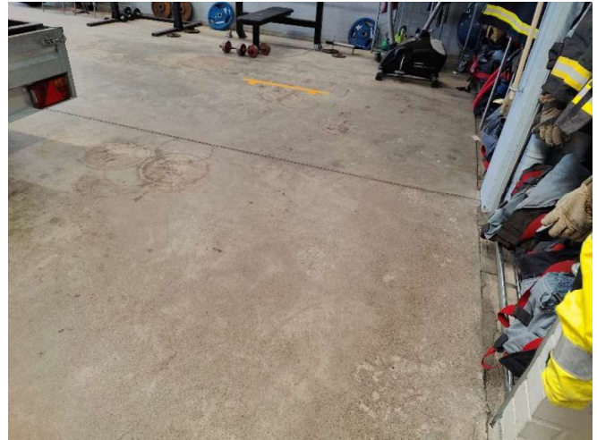
Kuva 18. Yleiskuva alapohjasta, halli.
