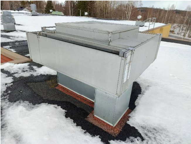
Kuva 52. LTO-patteri vesikatolla.
