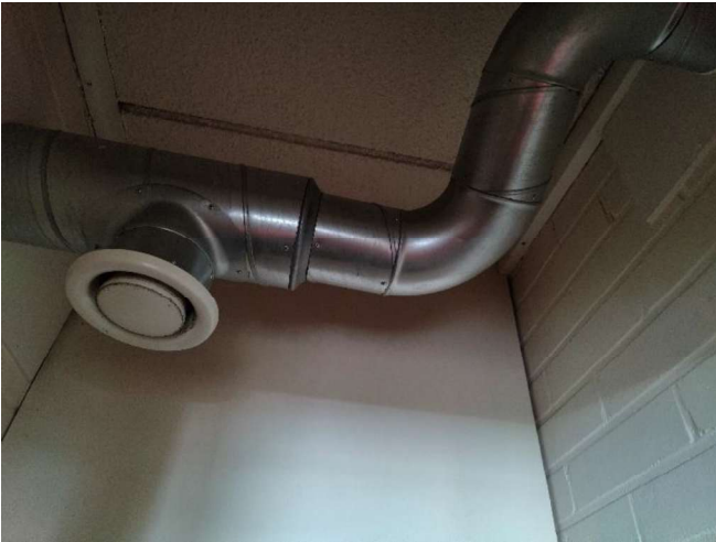
Kuva 108. Ilmanvaihtojärjestelmän kanavointia ja pääte-laite.
