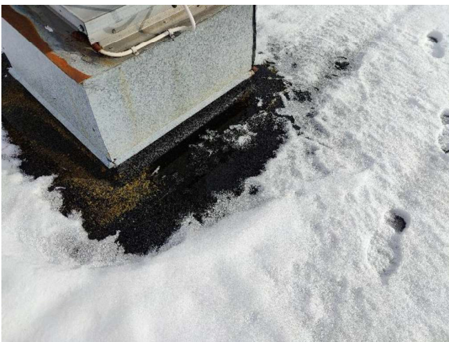
Kuva 50. Osassa nostoja vastakaato puutteellinen.
