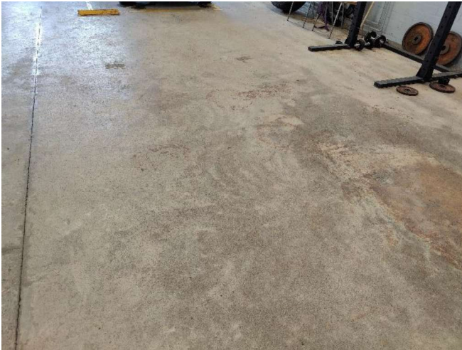
Kuva 17. Yleiskuva alapohjasta, halli.
