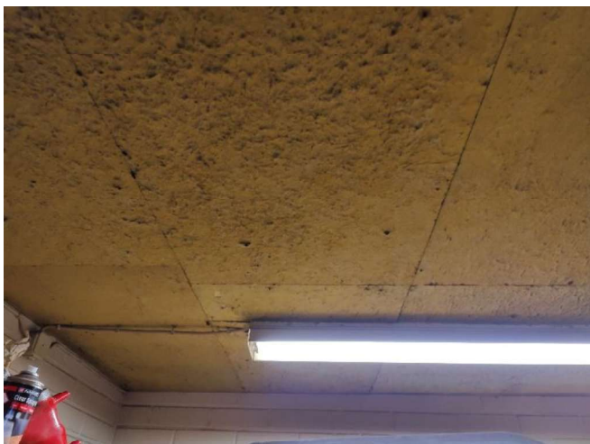
Kuva 68. Pinnoittamattomia villapintoja
