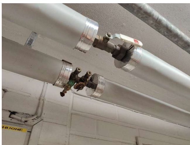
Kuva 91. Käyttövesiputket ja sulut.
